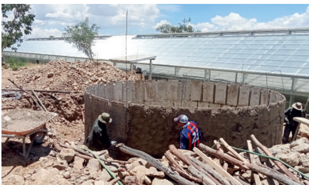
Proceso de construcción de la cisterna de cosecha de agua de lluvia en la ESFOR-UMSS.
